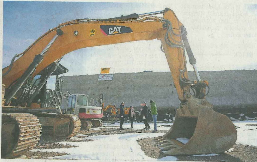
Eine mächtige Betonwand sichert den Hang zum Grundstück von Riese und Müller im Gewerbegebiet Ruckelshausen in Nieder-Ramstadt.
